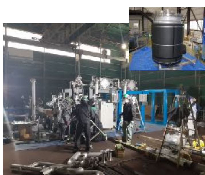
純空気製造装置（工場仮組時）
