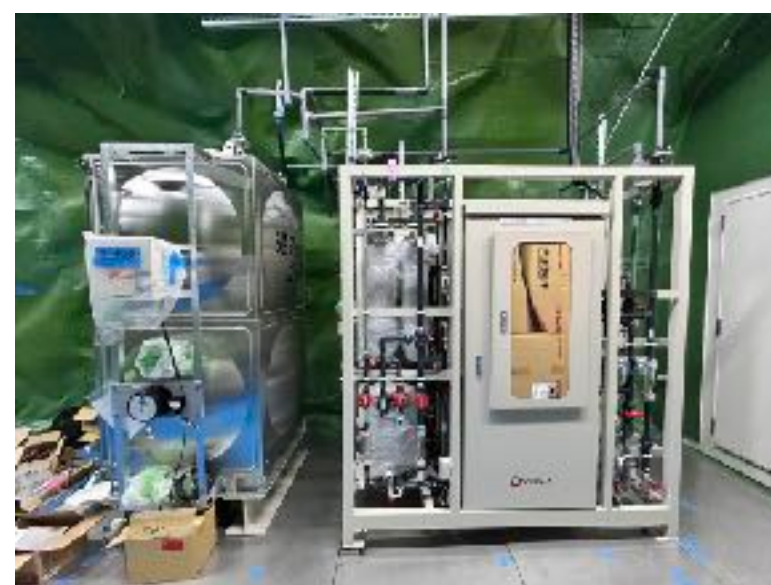
純水製造装置（搬入時）
