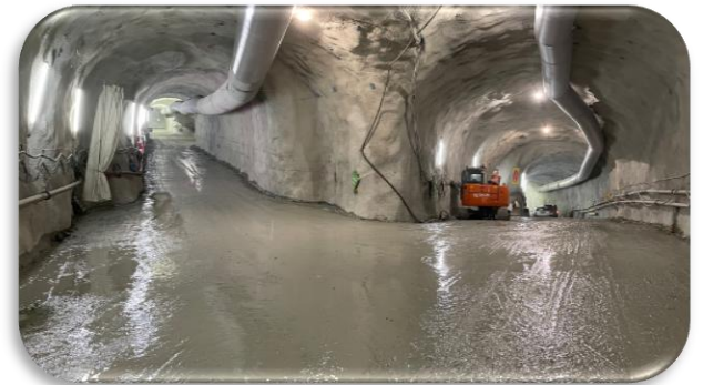
アクセス坑道掘削・舗装
