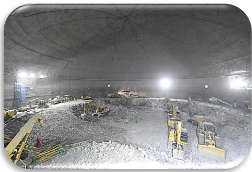
円筒部掘削-12m
