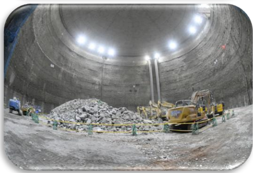
2024.8.5円筒部掘削-37m
