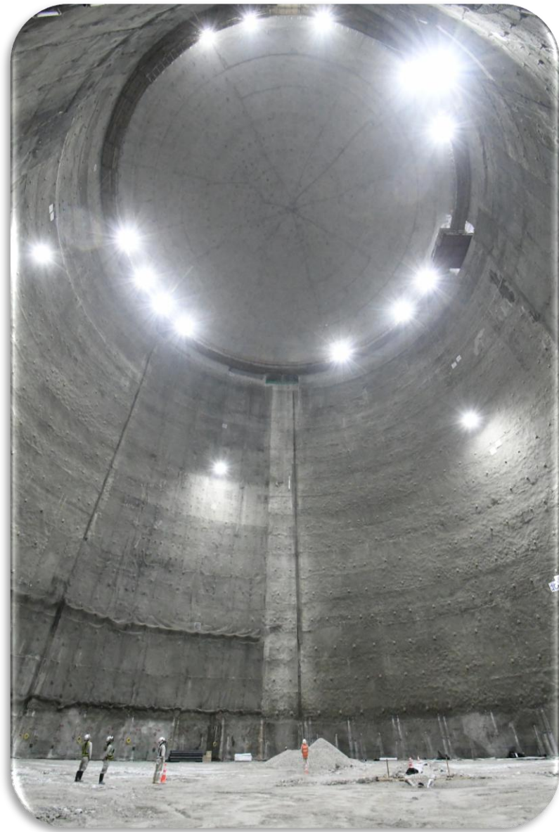
2025.7.31 空洞掘削完了
