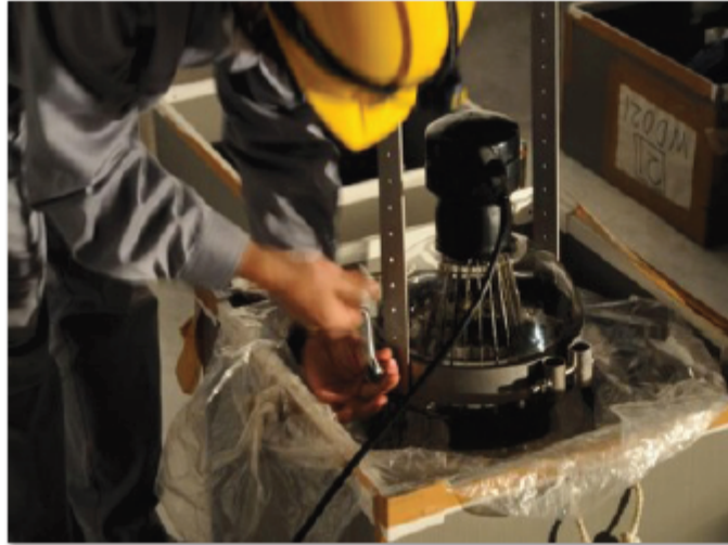
支持金具の取り付け
