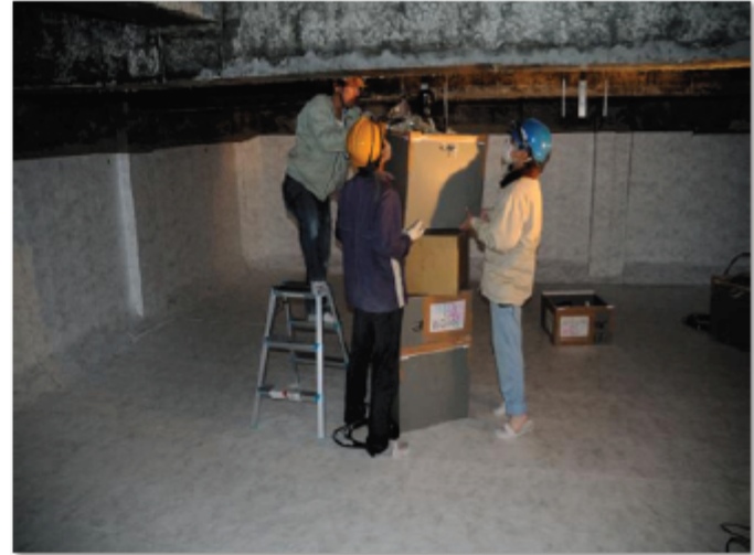
天井への取り付け
