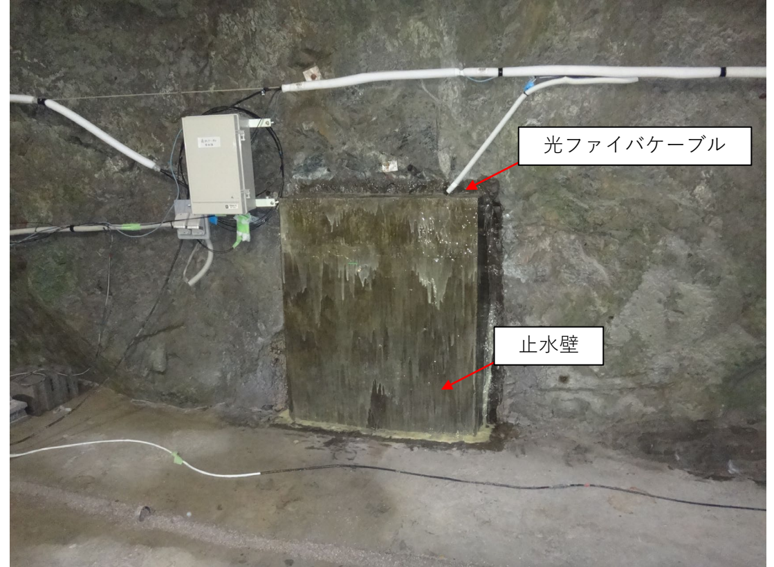
2022年6月 計測環境の安定化を図るため、東西孔へ止水壁を設けた。 作業は東西孔からの水の流出が落ち着いてから実施。
