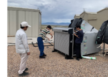
電動シャッター取付作業
